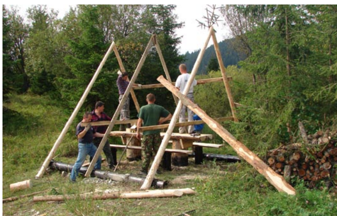
Pracovné tempo pri výstavbe prístrešku na Červenej skale
