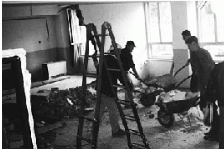
Takto začala rekonštrukcia OcÚ - vyst'ahovaním a búraním
