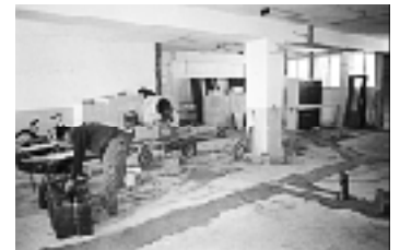
Po zbúraní priečok bolo potrebné dať do poriadku najprv kanalizáciu a rozvody vody
