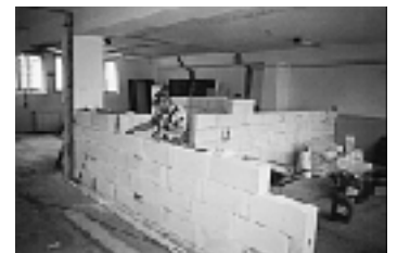
Nové rozmiestnenie kancelárií vyžadovalo vybudovanie nových priečok
