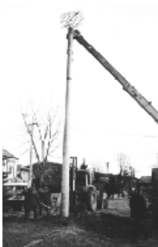
...a o niekoľko metrov ďalej postavili novú stĺp pripravenou kovovou konštrukciou pre nové hniezdo.
